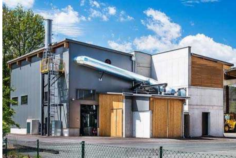
Figura 10: Planta de gasificació d'estella forestal per a cogeneració d'electricitat (180 kW) i calor (320kW) en una xarxa de districte a Pöllau, Austria (font: projecte Securechain).
