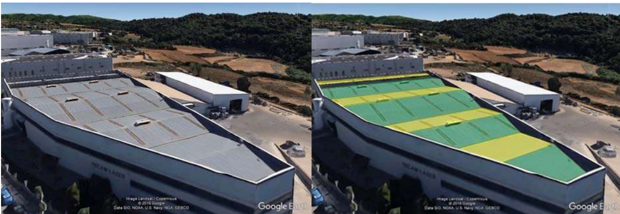
Figura 4: Coberta actual i render amb superfície captadora en una fàbrica de la província de Barcelona (font: Solartys, 2016)
