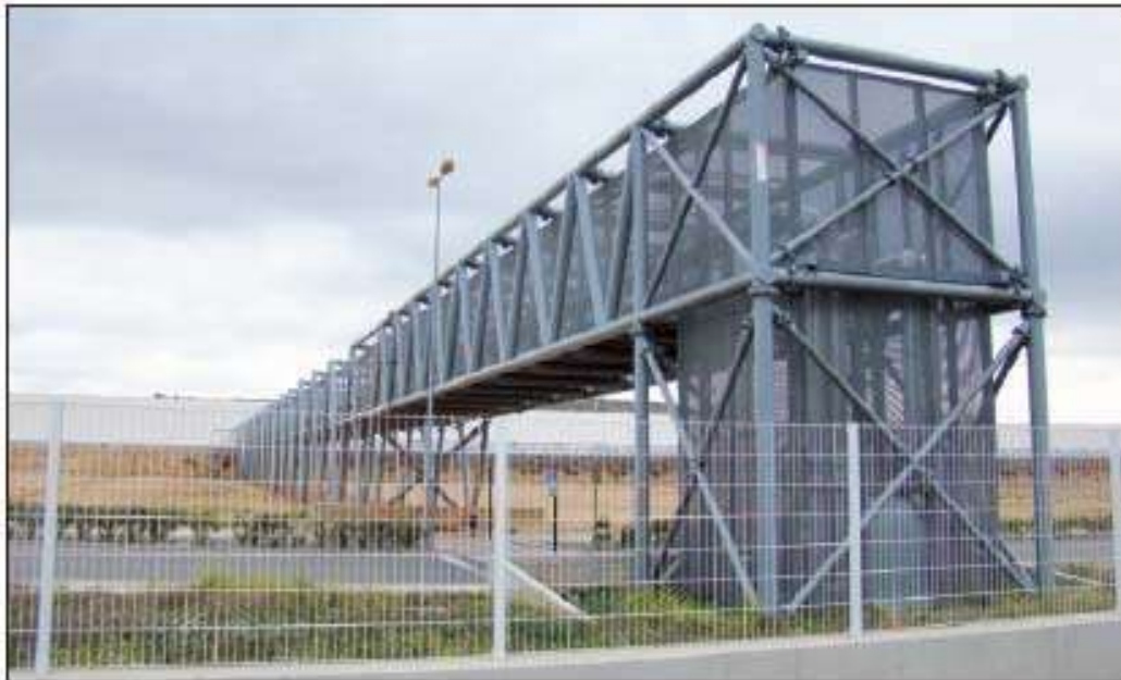
Figura 9. Vista de la xarxa de distribució en forma de rack aeri. (font: A. Ivančić)
